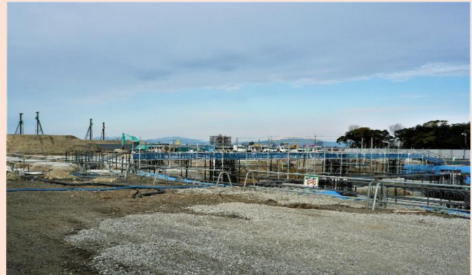
【観戦スタンド基礎工事】
